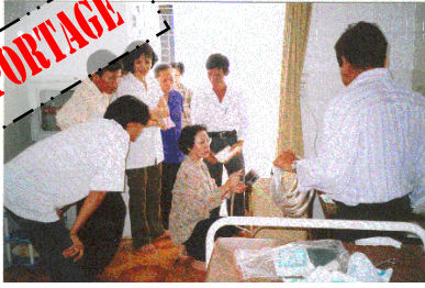
Installation du matériel au poste de santé de la commune de Long Binh
