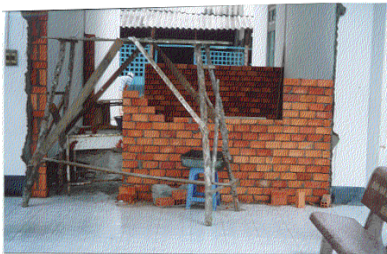
Travaux d'agrandissement de la maternité
